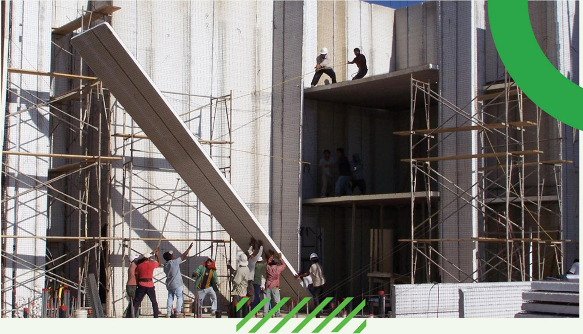
Le panneau EVG-3D est caractérisé par sa résistance unique qui résulte d'un dimensionnement parfaitement étudié du panneau en tant qu'élément de construction porteur, et par l'exécution irréprochable de la structure tridimensionnelle en treillis avec des fils écarteurs parfaitement droits sur toute leur longueur, d'un point de soudure à l'autre, et avec un maximum de points de soudure entre les fils écarteurs et treillis d'armature de couverture.
